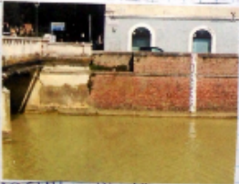
ARGINI IN MATTONI CON IDROMETRO
