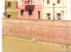
BOCCHETTONE NELL'ARGINE DI MATTONI
