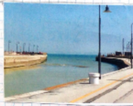
PORTO CANALE - FOCE DEL FIUME MISA BANCHINA DI LEVANTE
